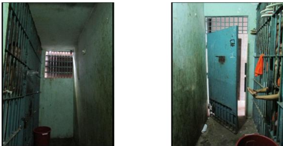
Figura 1 - Fotos da cela “Triagem Velha” (Relatório de visita ao Complexo Penitenciário de Pedrinhas, 2015, p.7 )
