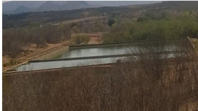
Fotografia 3 – Local de captação de esgoto
