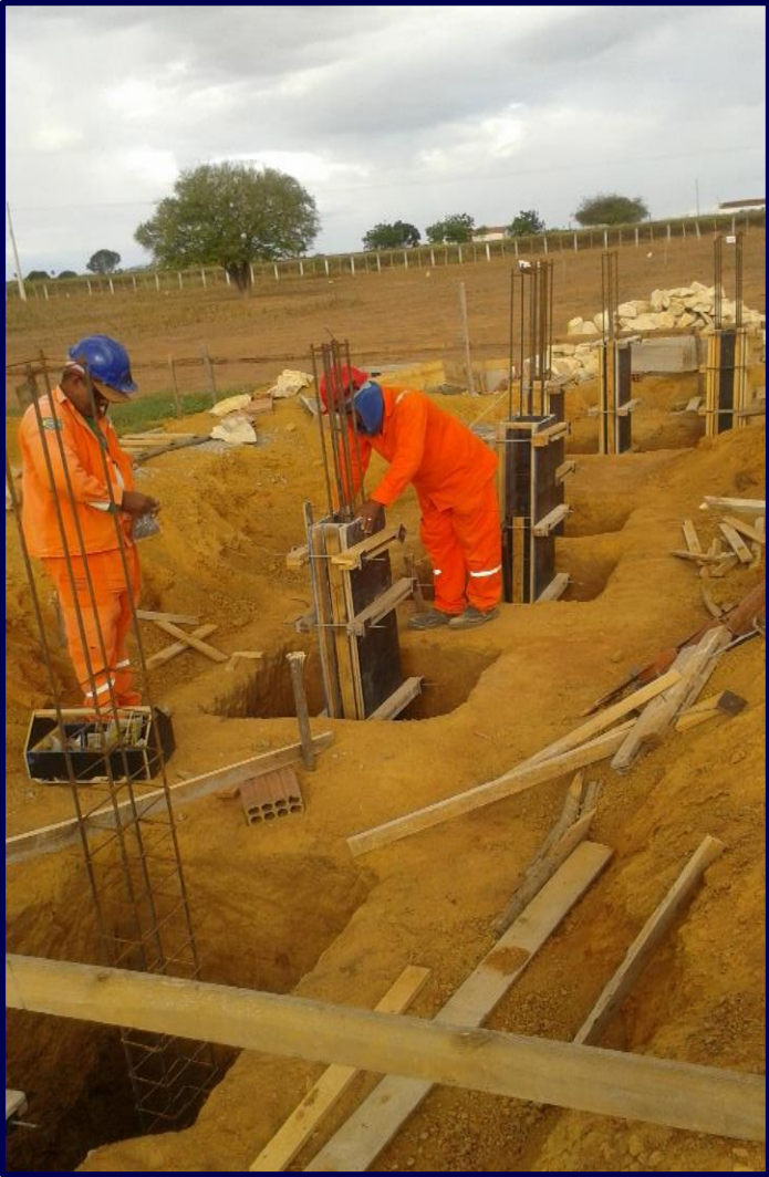
<<<<<<< * Montagem das formas na ferragem dos pilares.
