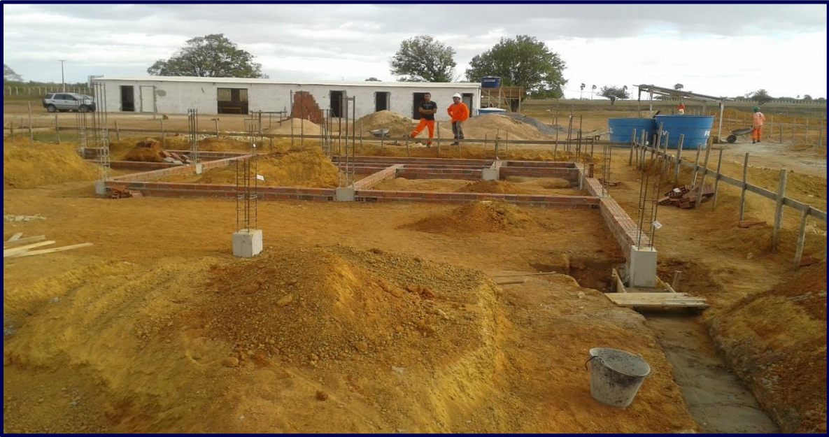
* Alvenaria de tijolo sobre a alvenaria de pedra >>>>>>>
