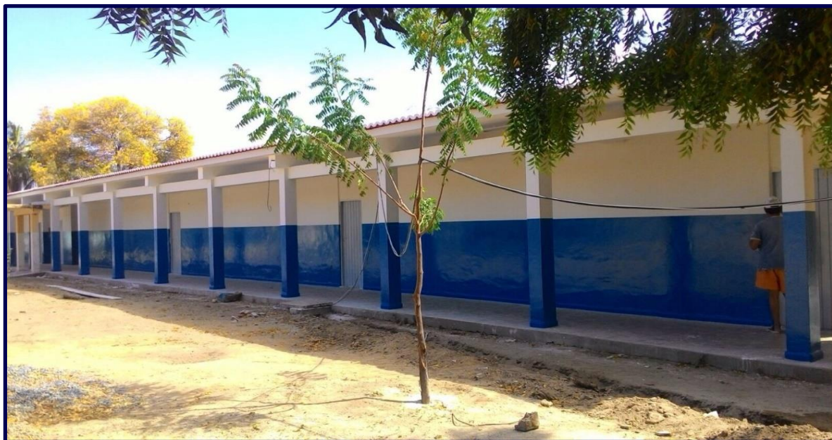
* Acabamento da fachada interna da edificação.
